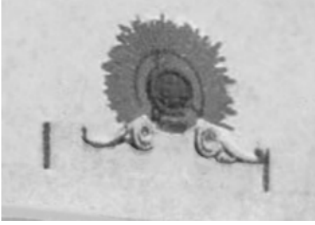
Giriş alınlığında âfitâb - güneş simgesi.
